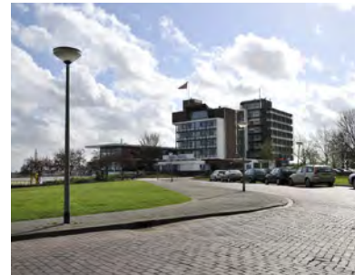
Het hotel aan de Maas heeft een samengestelde massa
