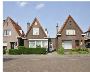
Kleinschalige lintwoningen met een individuele uitstraling aan de Soendalaan
