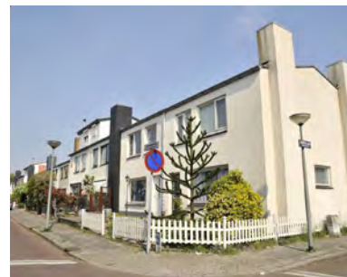
Rijen woningen aan groene straten in een sobere baksteenarchitectuur
