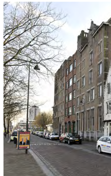
Materialen en kleuren zijn ingetogen, verouderen mooi en passen in het traditionele straatbeeld
