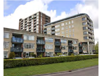
De individuele woning in een appartementencomplex is deel van het geheel
